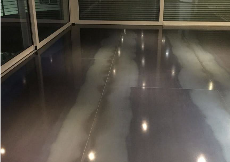
Nuova pavimentazione in lastre di ferro con punti di saldatura a vista
